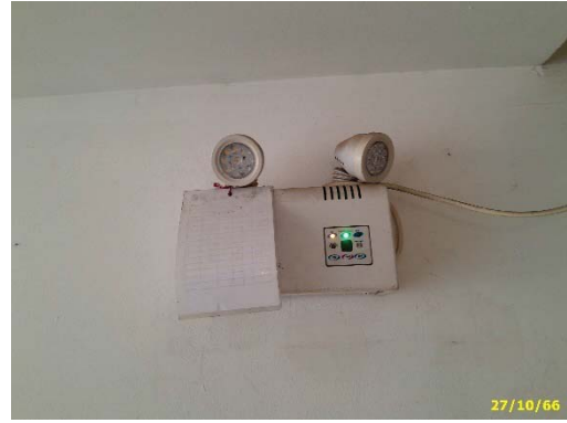
ระบบไฟฉุกเฉิน (Emergency Light)
